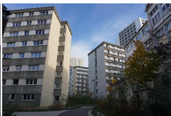
Cité des Poissons entrée rue Arthur Rozier
